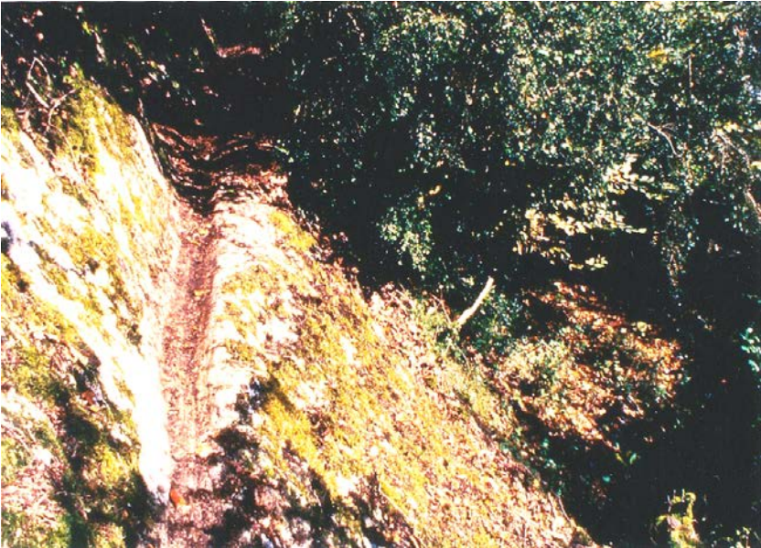
In den Fels eingetieftes Karrengleise. Die Fahrspur zeigt ein nicht mehr vorhandenes Wegtrasse an. Standort oberhalb von Oberbuchsiten, Blick Richtung Nordosten. (Foto Andreas Motschi, Oberbuchsiten)
