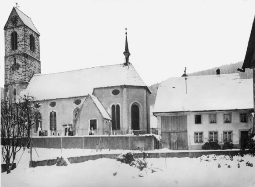
Ansicht von Südosten, rechts das Haus von Karl Motschi
