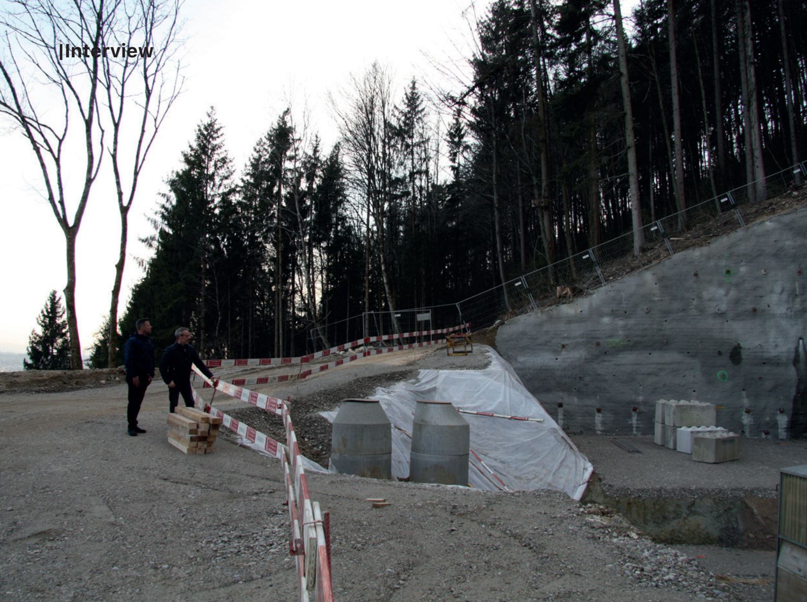
Oberhalb des bestehenden Reservoirs Hard entsteht das neue Reservoir. Im Herbst soll es in Betrieb genommen werden.
