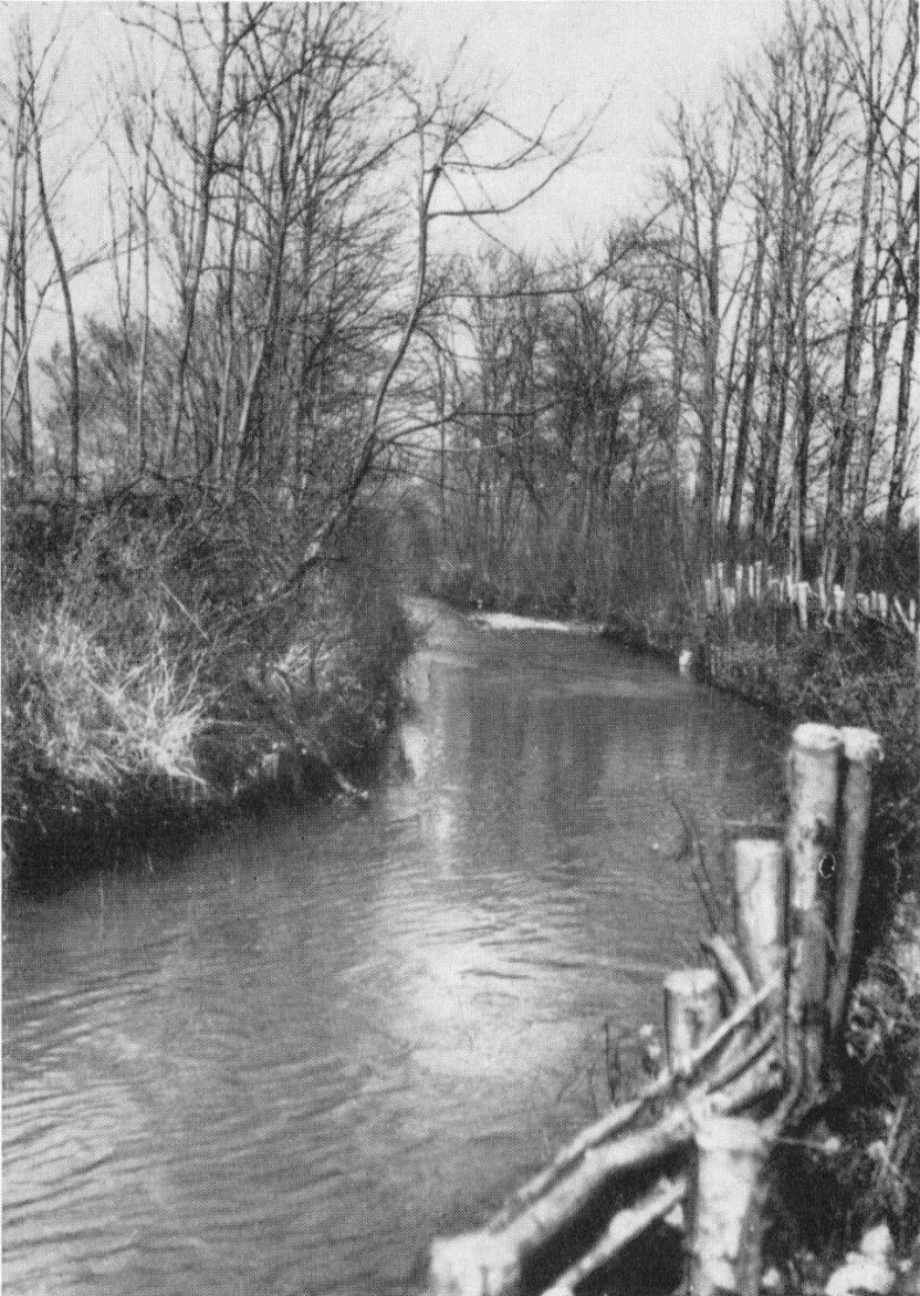
Alte Dünnern zwischen Oensingen und Oberbuchsiten. Die Uferdämme sind durch Pfahlwerk geschützt
