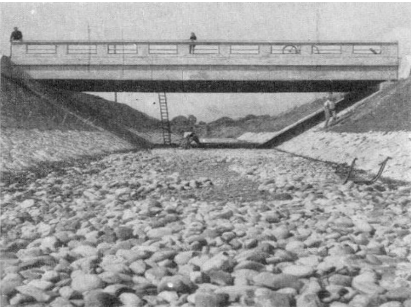
Schälismühlebrücke in Oberbuchsiten
