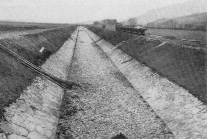
Fertiger Kanal von der Schälismühlebrücke gegen Oensingen
