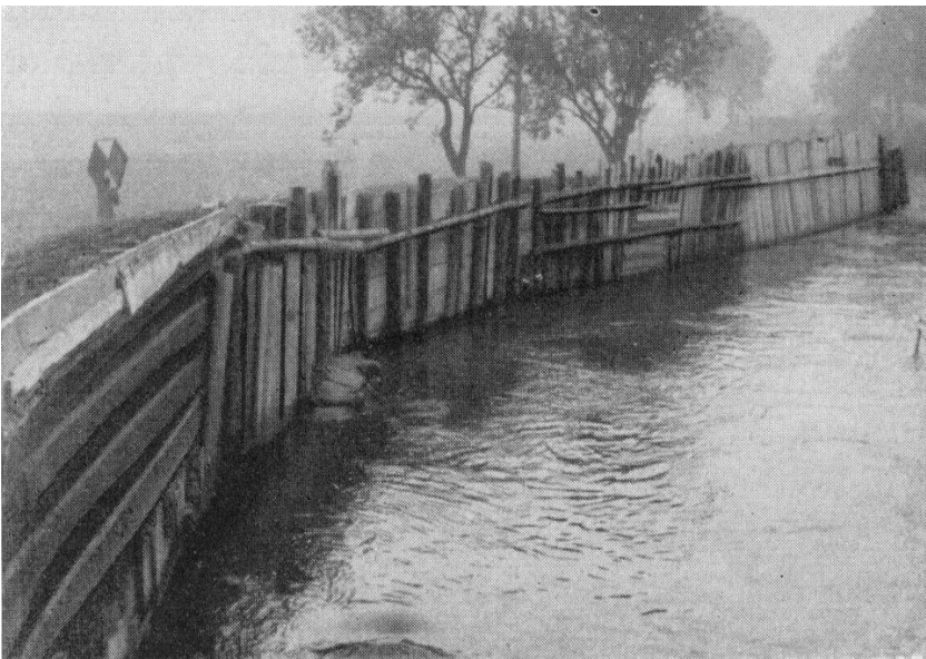
Im Schachen von Oensingen. Ufer durch Bretterwände gesichert
