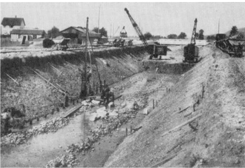
Kanalbau bei der Egerkinger Brücke
