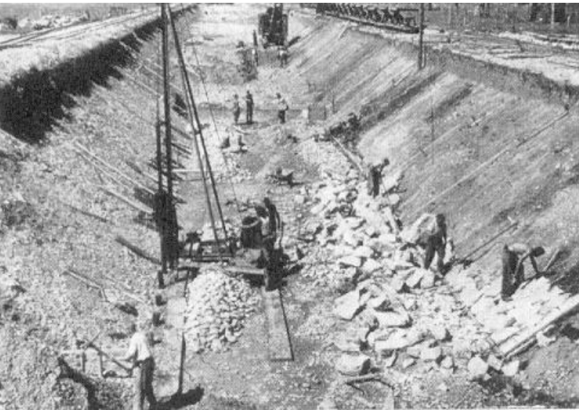
Aufsetzen von Böschungspflaster
