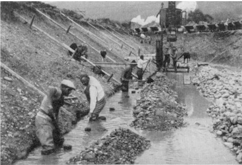
Aushub für die Längsschwellen
