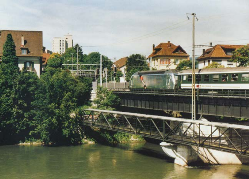
Jubiläumsslok Re 460 auf der neuen Gäubahnbrücke
