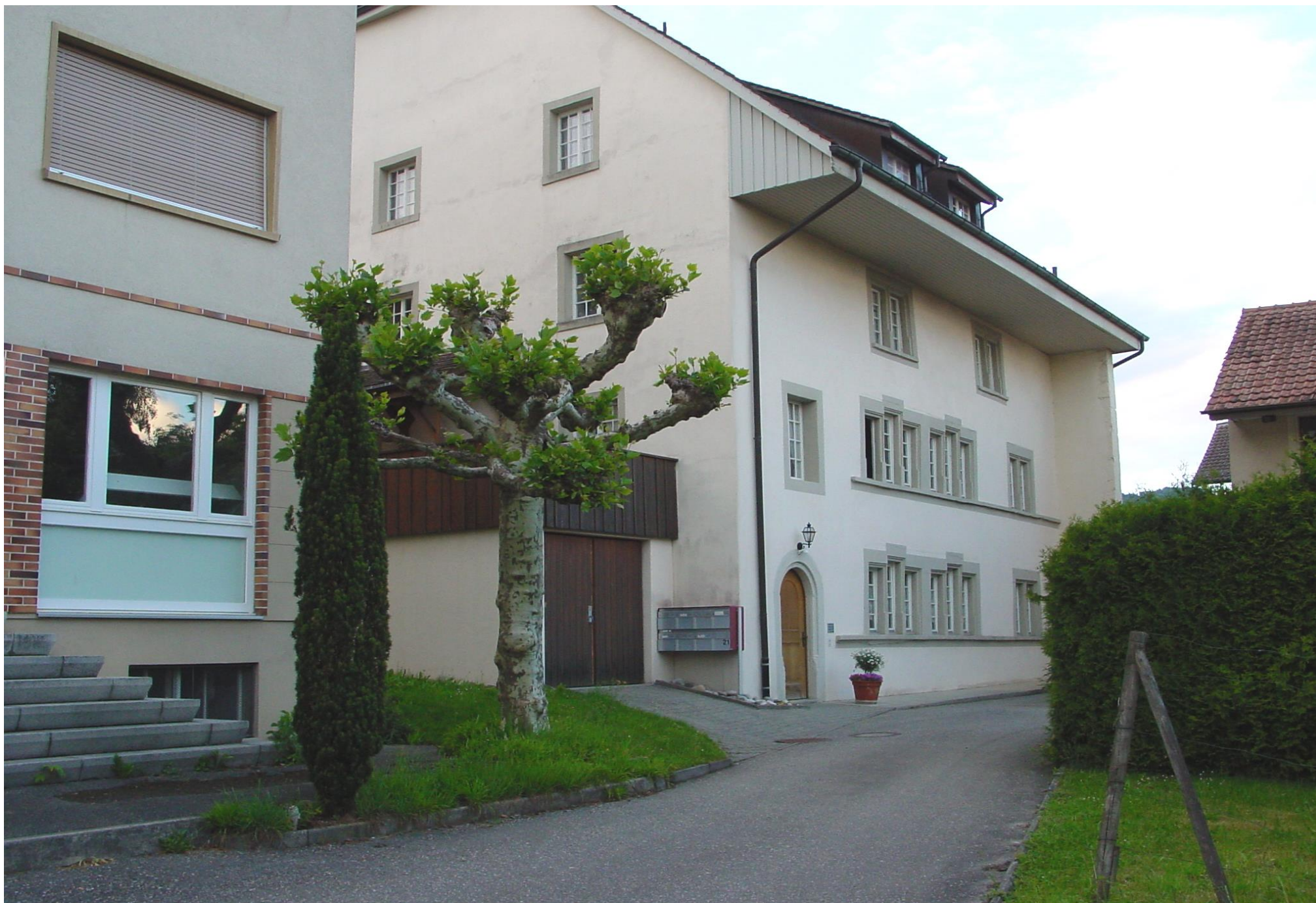
Das Zehntenhaus von Oberbuchsiten im Frühling 2003
