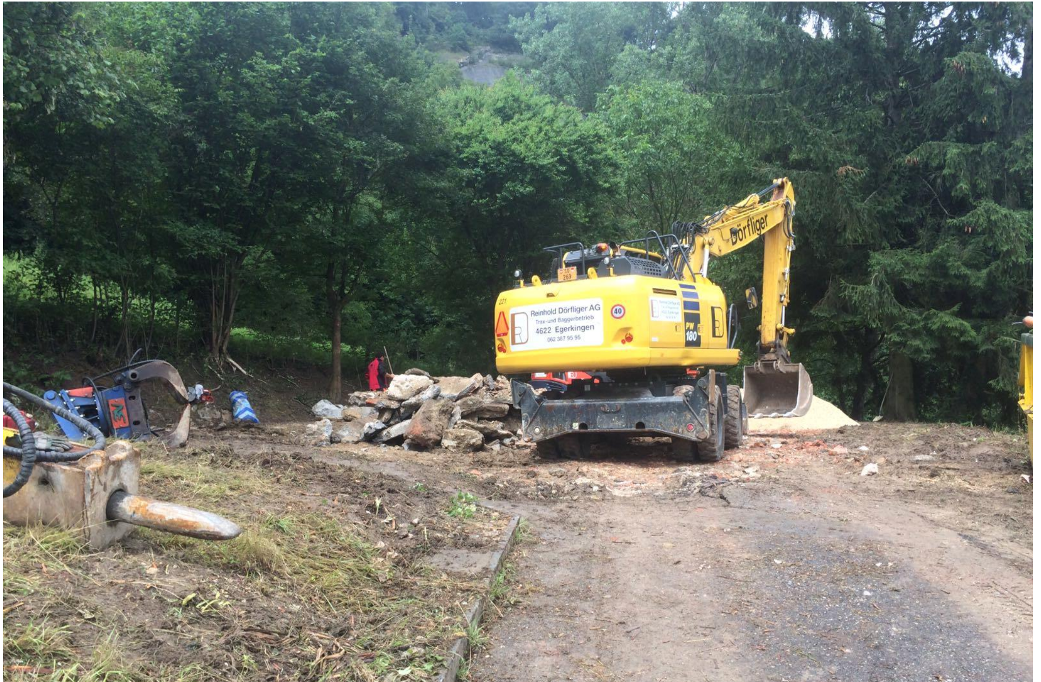
Abbruch im Juli 2016
